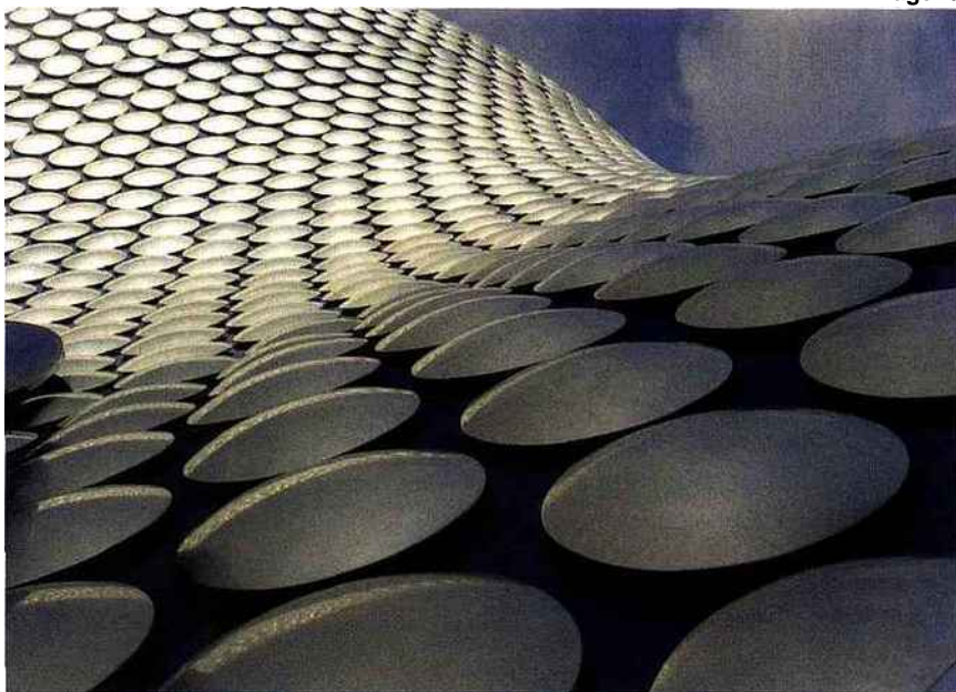
Galets. Future Systems a recouvert le magasin Selfbridges a Birmingham de disques d'aluminium.
