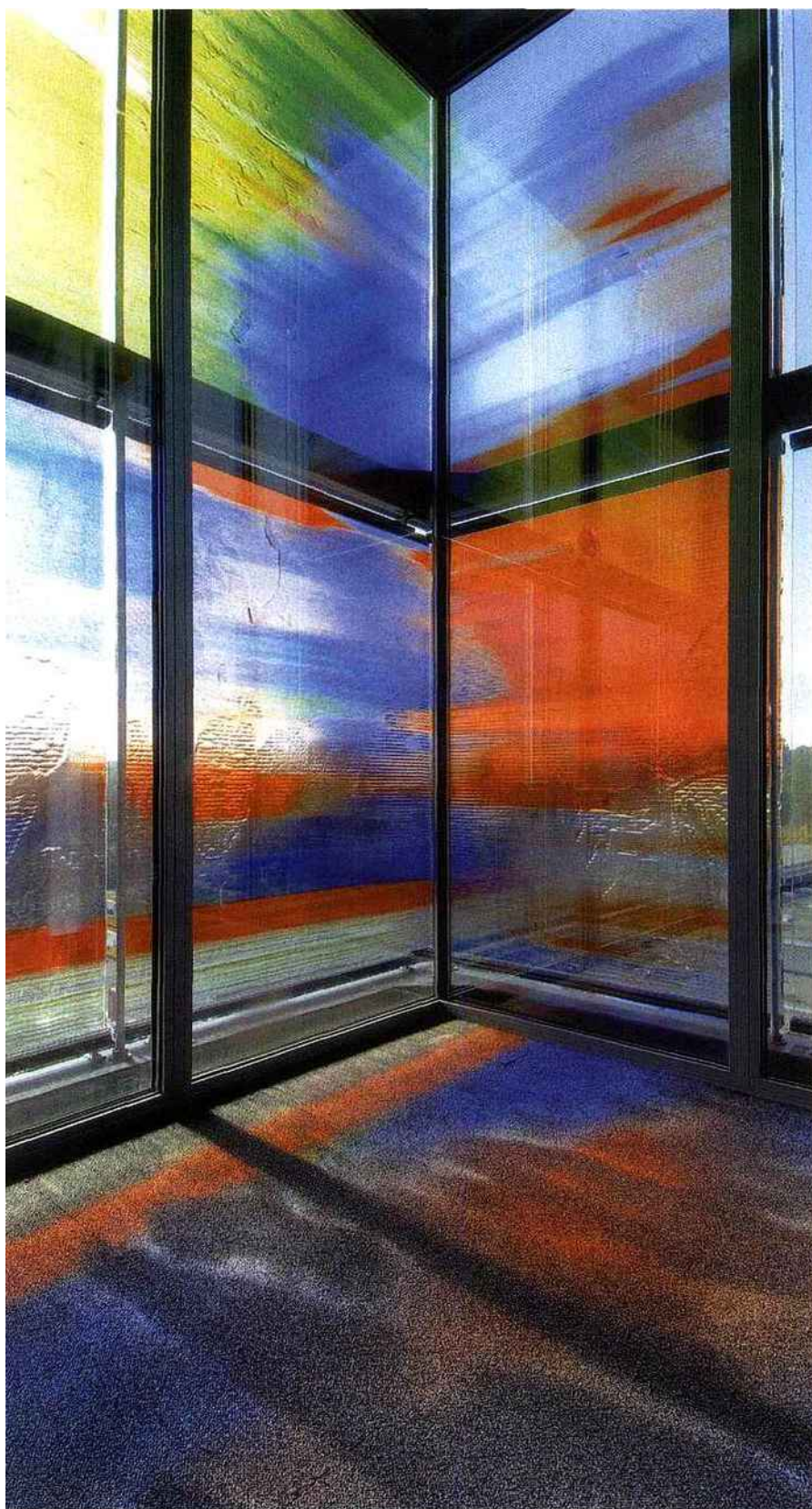
Vitrail High-tech. Le verre Crea-Lite peut reproduire les couleurs et les reliefs.
